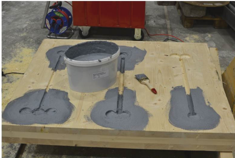
Abbildung 4-11 Brandschutzanstrich auf einem Brettsperrholzelement im Bereich von Ausnehmungen für den Einbau von elektrischen Installationen.
